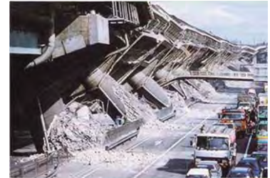
兵庫県南部地震による高速道路の倒壊 出典：神戸新聞 NEXT http://www.kobe-np.co.jp/
